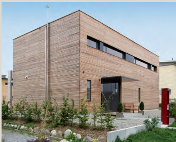
Ein Vordach und ein holzbeplanktes Podest setzen den notwendigen Akzent am Eingang.
